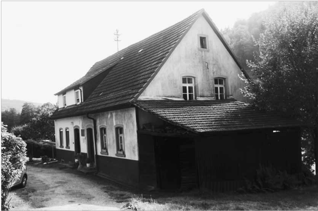
Abb.1: Haus der Familie Remmele in Altneudorf bei Heidelberg, heute Ortsteil von Schönau im Odenwald
